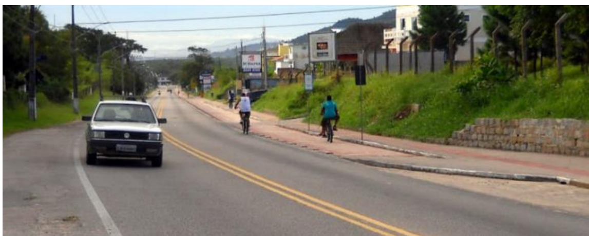
Figura 27. Ciclofaixa com tachões bidirecional da Avenida Pequeno Príncipe, Bairro do Campeche. Fonte: Acervo Ciclo Observatório (ViaCiclo)
