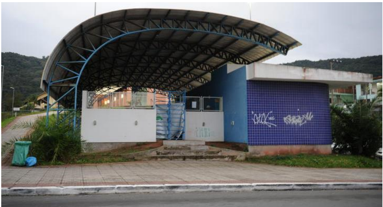
Figura 35. Bicicletário no Terminal de Integração da Lagoa (TILAG). Hoje em dia utilizado como sala de descanso para os motoristas de ônibus. Fonte: Fabiano Faga Pacheco
