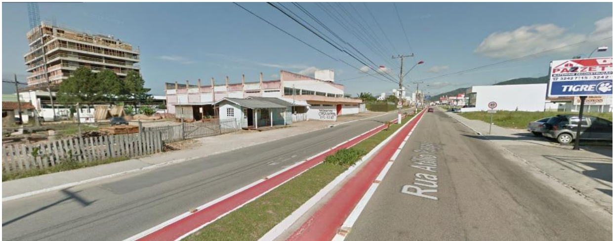
Figura 33. Ciclofaixa com tachões no canteiro central da Rua Atílio Pagani. Fonte: Google Street View
