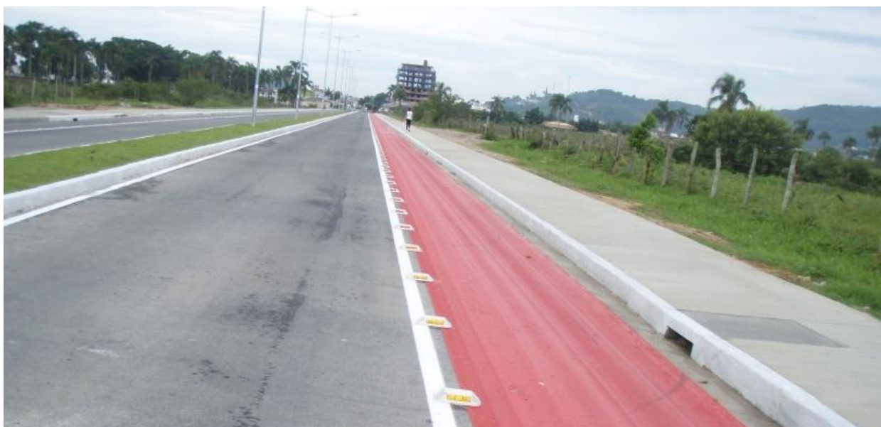
Figura 34. Ciclofaixas com tachões e unidirecionais no município de Biguaçu. Exemplo da Rua Bento dos Santos. Fonte: Antônio Carlos de Azevedo
