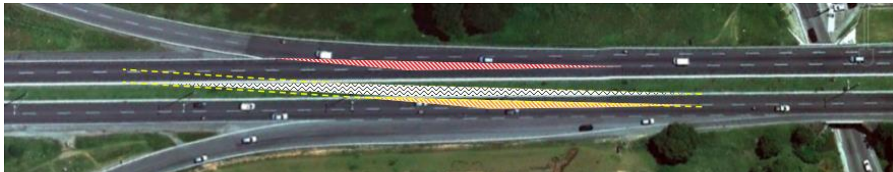
Figura 73 – Cortes no canteiro central do acesso Oeste
