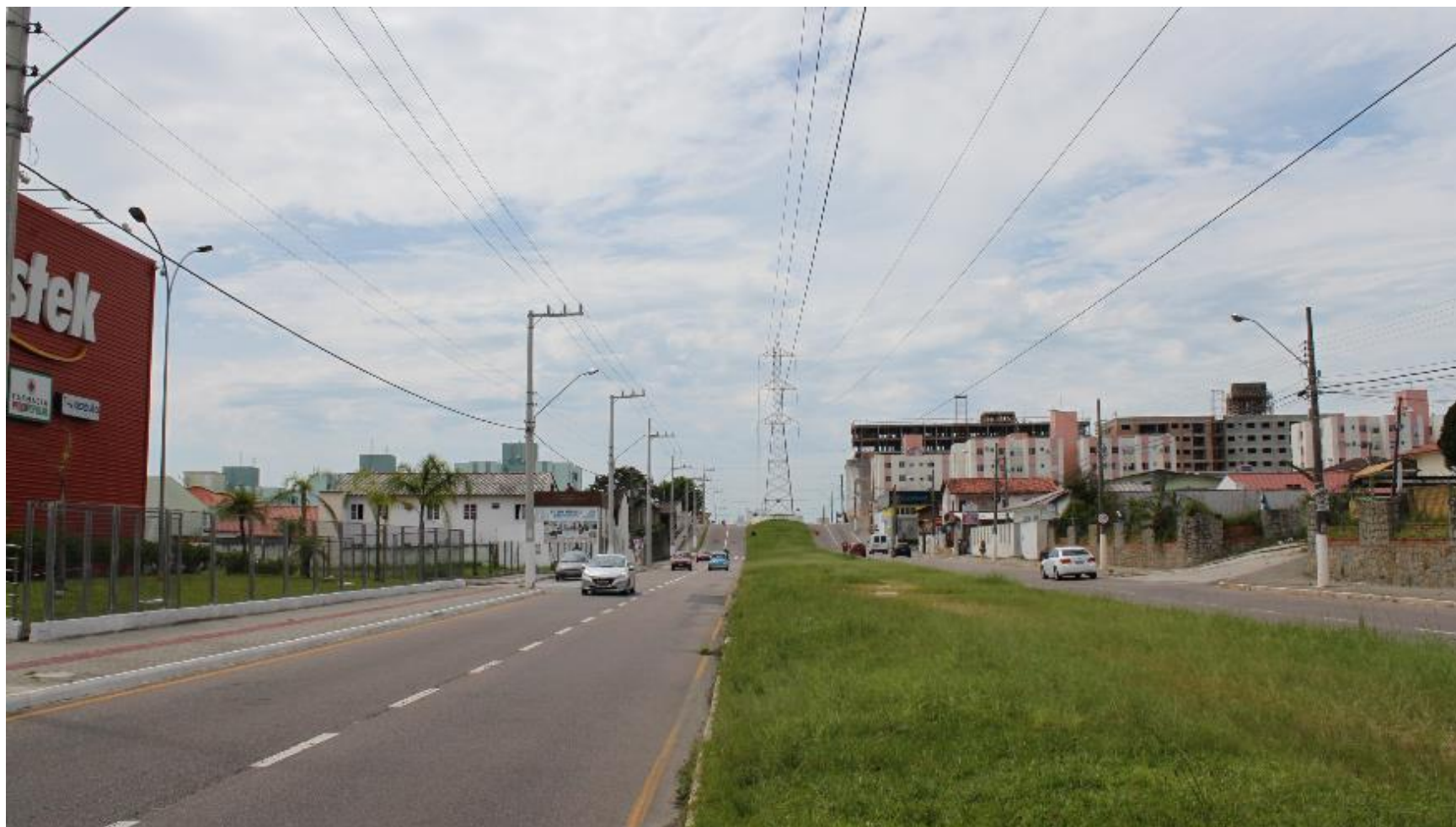
Figura 3-55: Vista atual da Avenida das Torres
