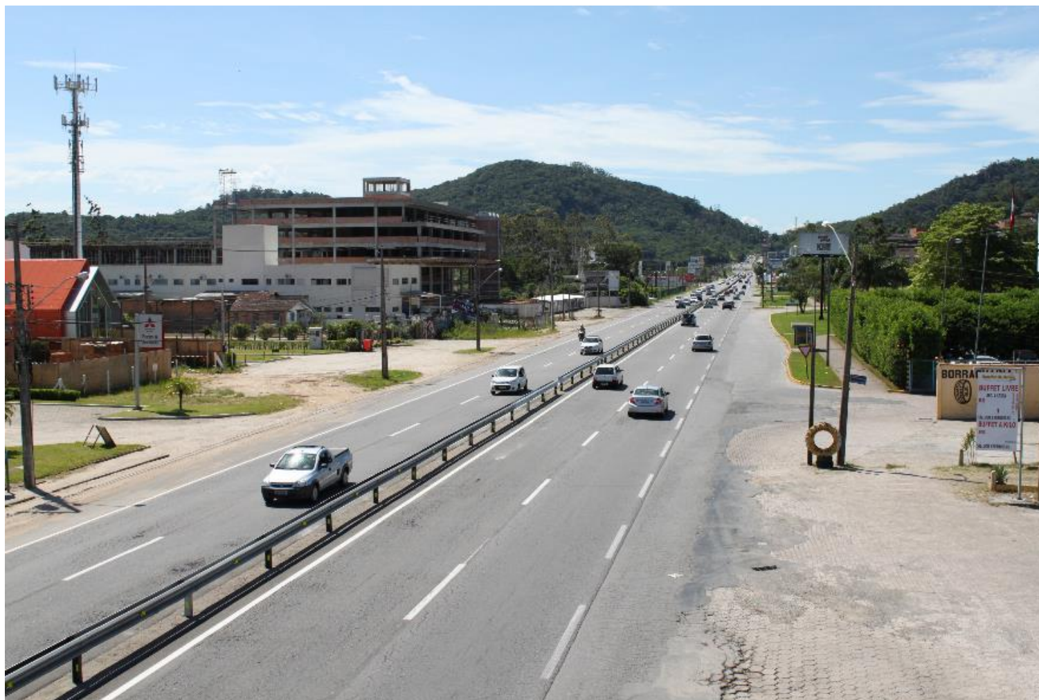
Figura 3-51: Vista atual da SC-401.
