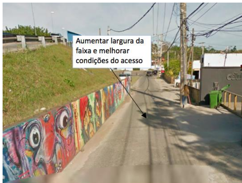
Figura 3-32- Faixa de acesso existente do bairro João Paulo para a SC-401, sentido Sul.
