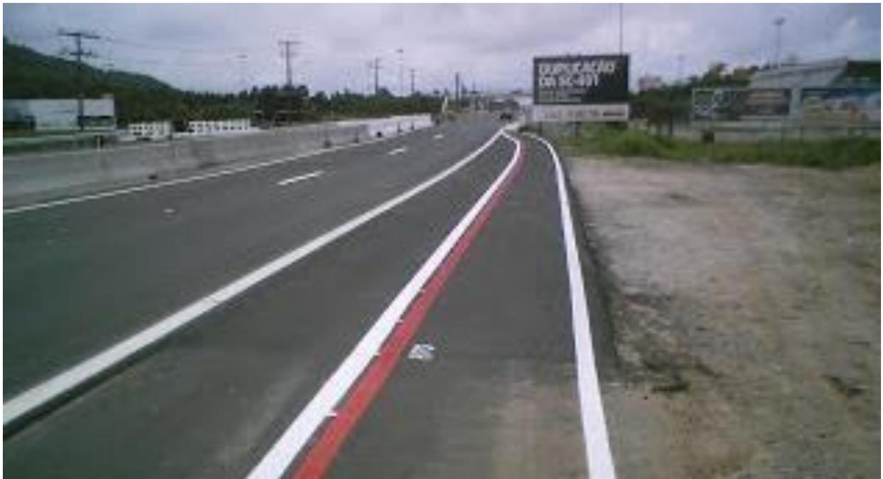
**Figura 62. Ciclofaixa com tachões da SC-401. Fonte: Acervo Ciclo Observatório (Viaciclo)**
