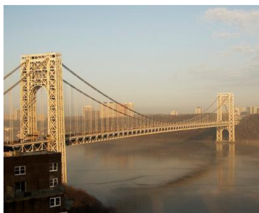
Figura 7 – Ponte George Washington em Nova Iorque
