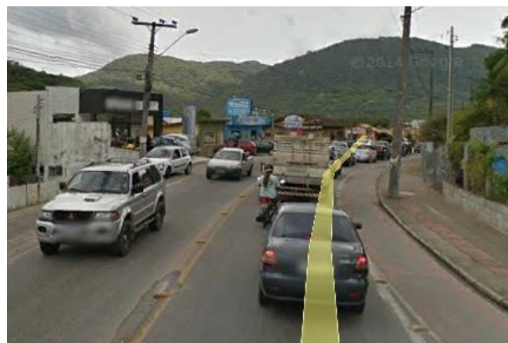
Figura 181 - SC- 405 entre a Av. Pequeno Príncipe e o entroncamento com a SC-406
