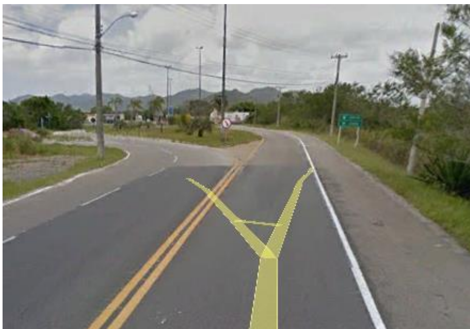
Figura 167 - Rodovia Pontal do Jurerê, entroncamento com a SC-402 – Saída de Jurerê
