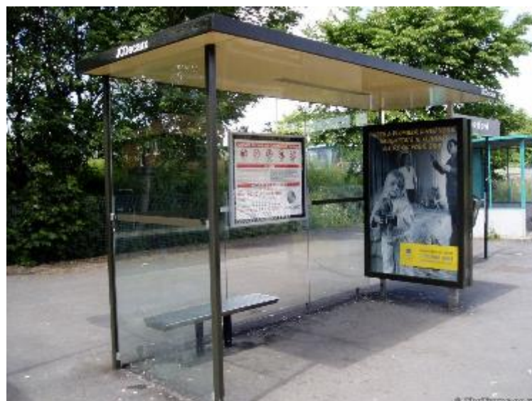
Figura 78 – Abrigo Francês com painel de publicidade na lateral oposta à chegada do veículo, vidro para proteção contra intempéries, informações ao usuário no painel traseiro e teto em fibra de vidro
