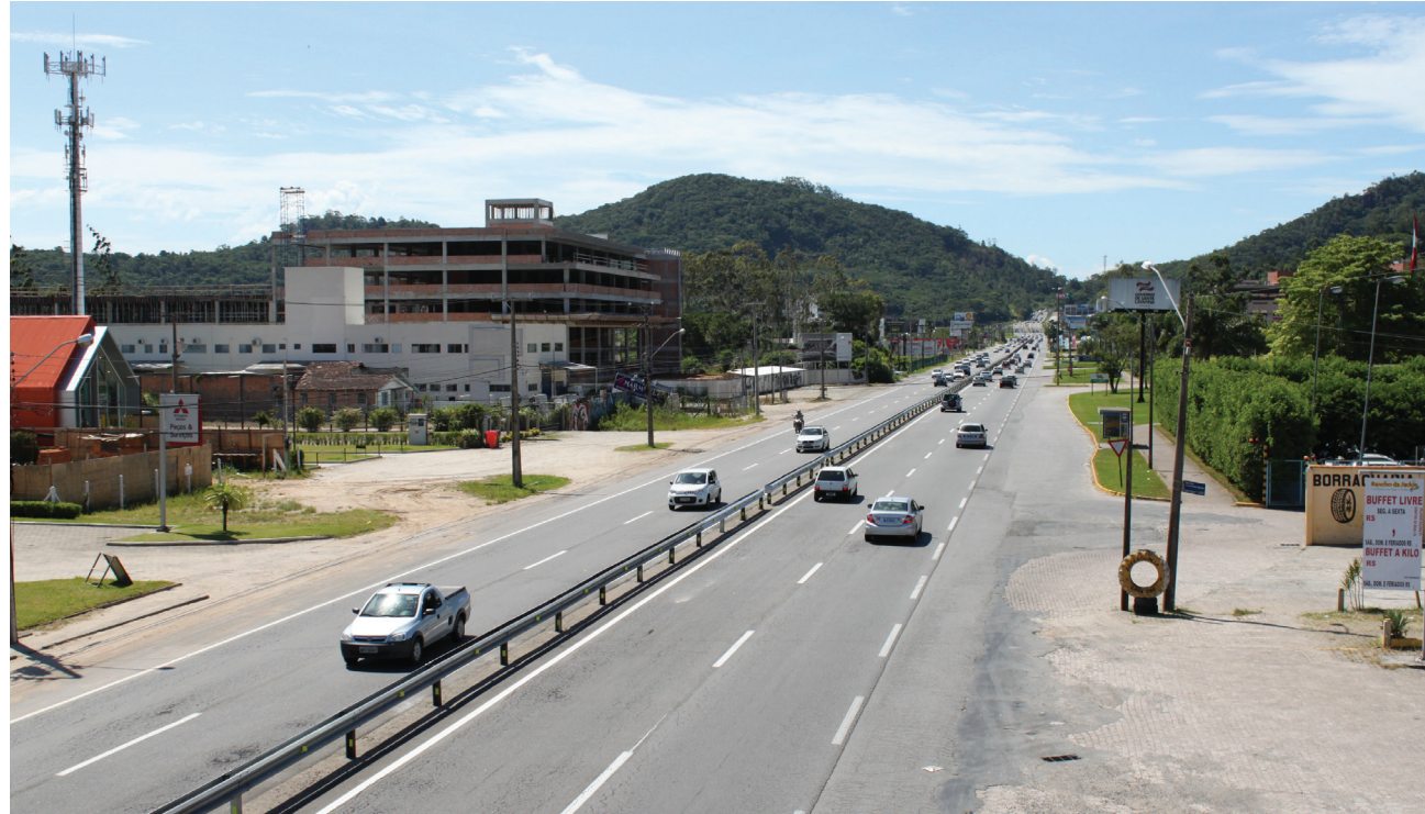
Figura 35 Vista atual da SC-401. Fonte: Vitor Sadowski.
