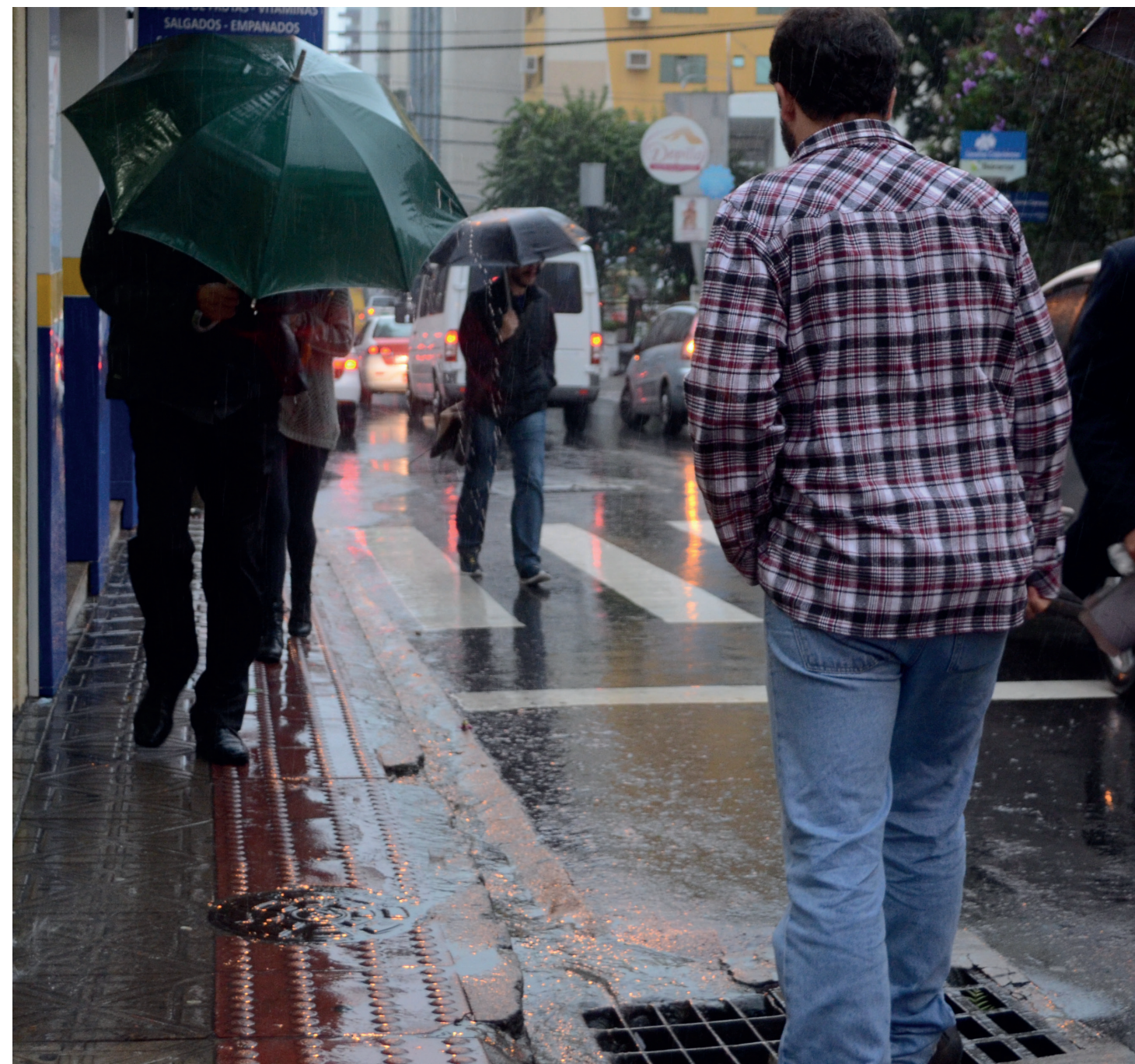
Figura 7 Calçadas estreitas e rede cicloviária precária. Foto: ZAPTA.
