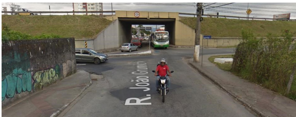
Figura 65. R. João Grumiche - Trecho ao norte. (Fonte: Google Street View).
