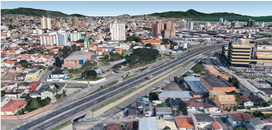
Figura 82. Situação atual do trecho da BR-101 previsto para locação da estação Correios (Fonte: Google Earth).
