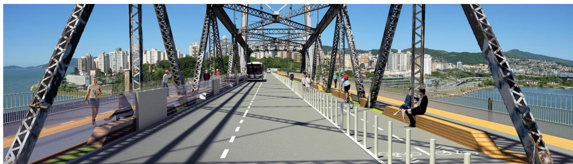
Figura 28. Proposta para a Ponte Hercílio Luz. Inserção de faixas exclusivas para os ônibus, ciclovias e passeios. Vista do vão central.
