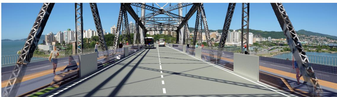
Figura 29. Proposta para a Ponte Hercílio Luz. Inserção de faixas exclusivas para os ônibus, ciclovias e passeios. Vista do vão central.
