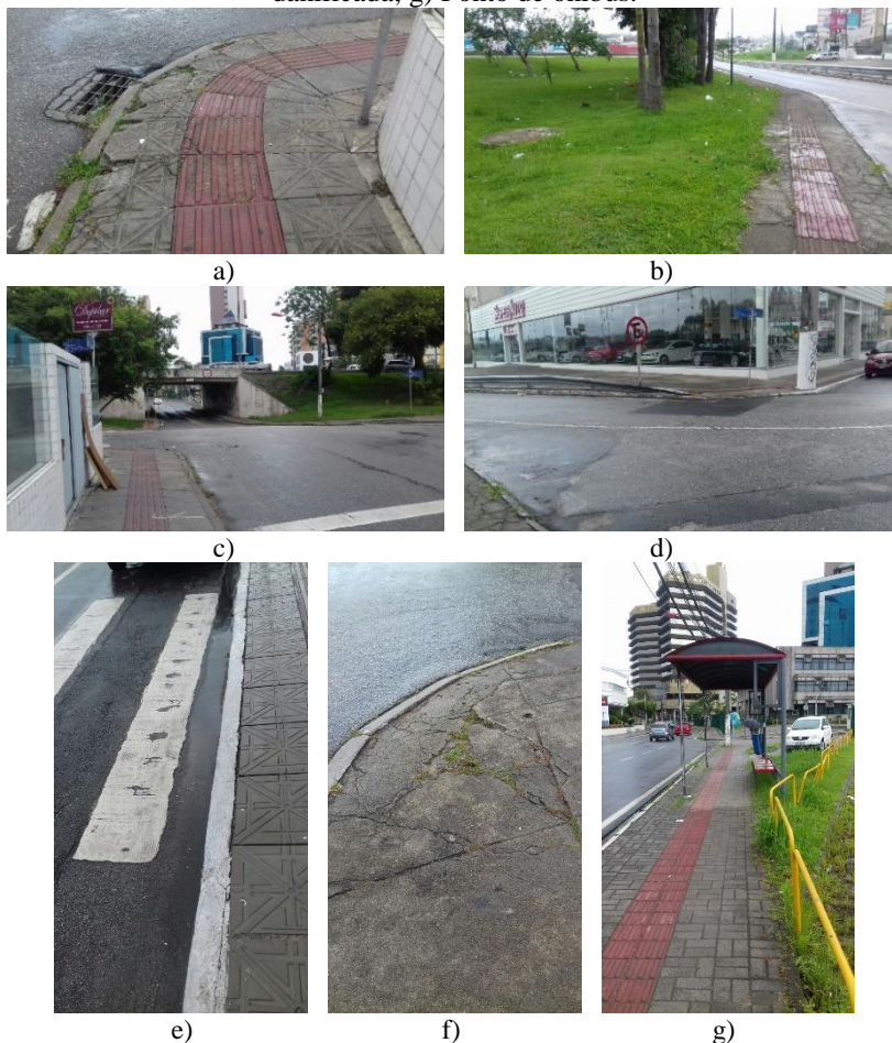
Figura 43 – Calçada e ruas próximas à Estação Lédio: a) Calçada mal conservada; b) Lixo e calçada danificada; c) Viaduto da Rua Koesa; d) Inexistência de faixa de pedestre; e) Meio fio não rebaixado; f) Calçada danificada; g) Ponto de ônibus.
