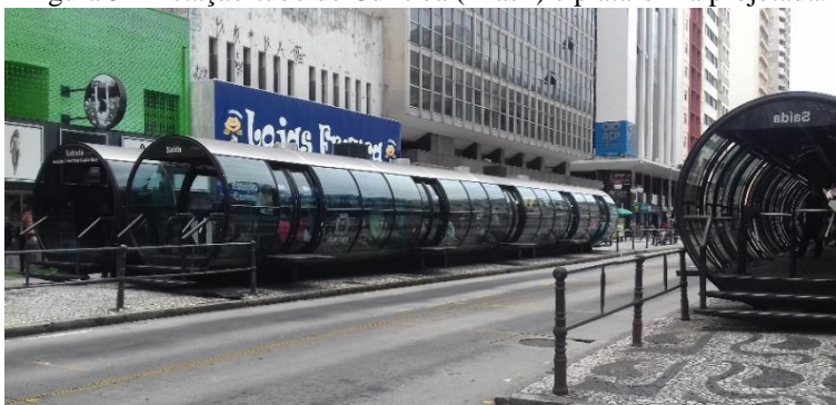
Figura 5 – Estação-tubo de Curitiba (Brasil) e plataforma projetada.
