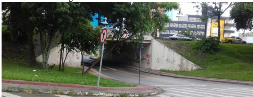
Figura 42 – Viaduto sobre a Rua Koesa.
