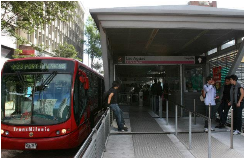
Figura 2 - Estação de BRT de Bogotá
